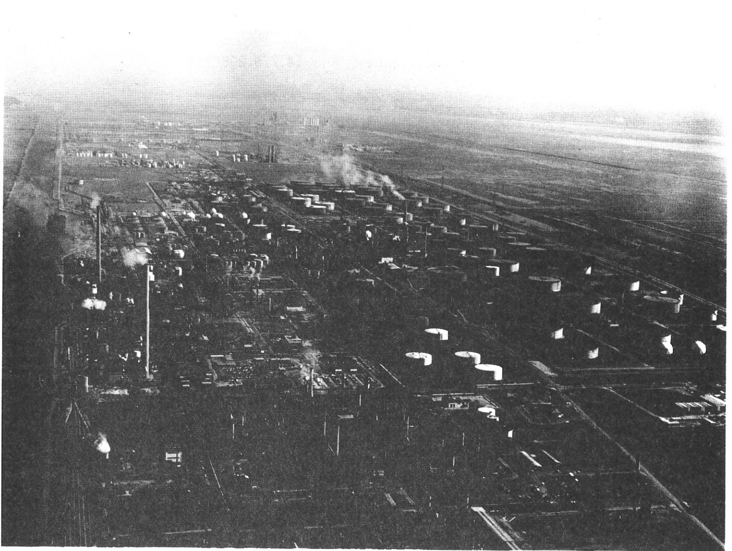
Fig. 16.- Raffinerie de Normandie
