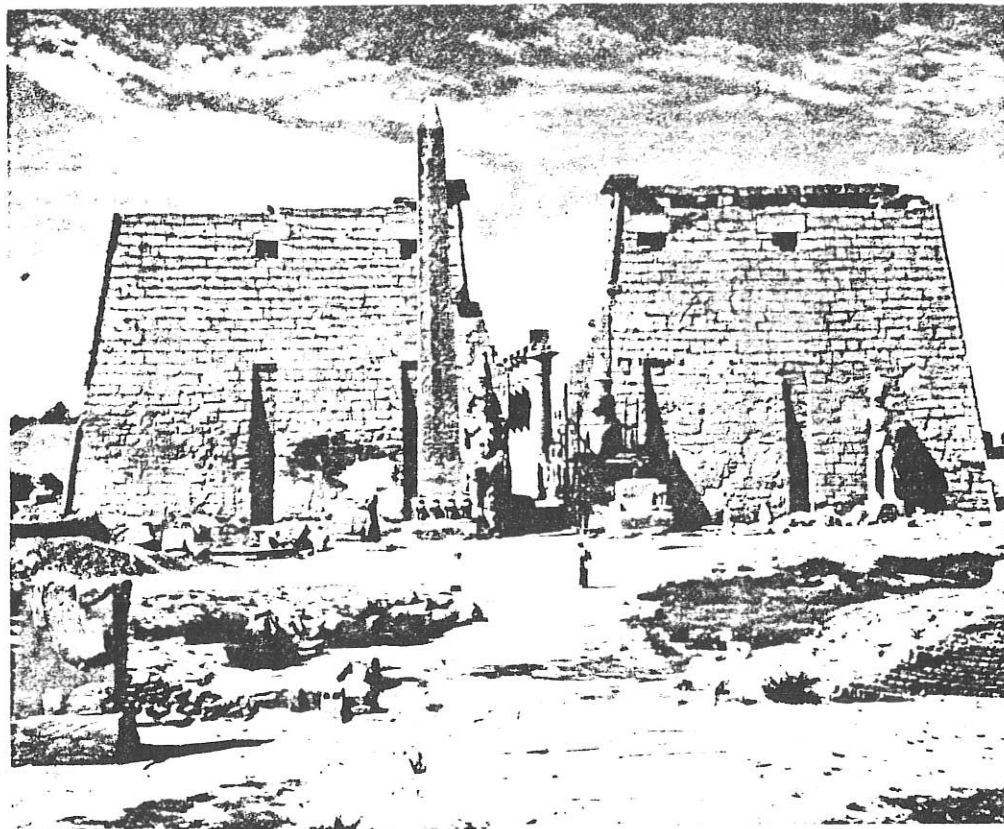
Photo 22.- Le pylône du temple de Louxor.
